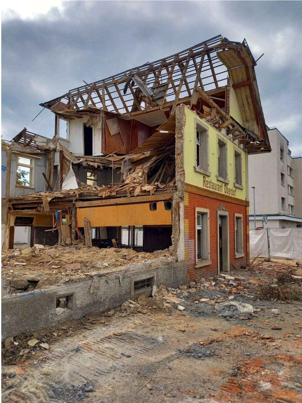
Rückbau Restaurant Oberdorf Herbst 2021
