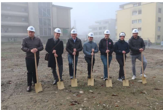
Spatenstich November 2021 Baustellenfoto April 2023
